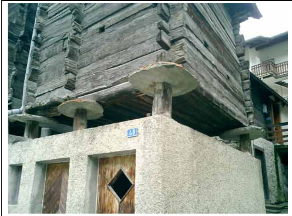
Zermatt, alter Speicher
